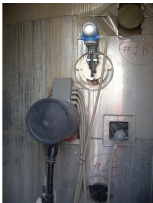
Slika 3: Merilno mesto na dimniku.
