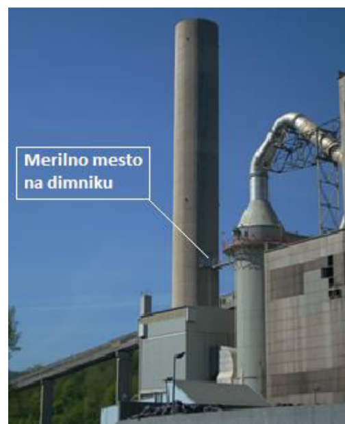
Slika 1: Dimnik peči z označenim merilnim mestom.
