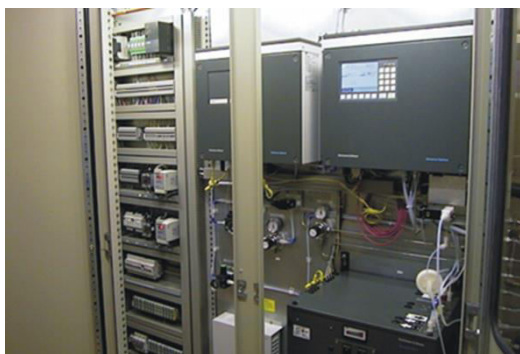
Slika 4: Merilniki emisij dimnih plinov.
