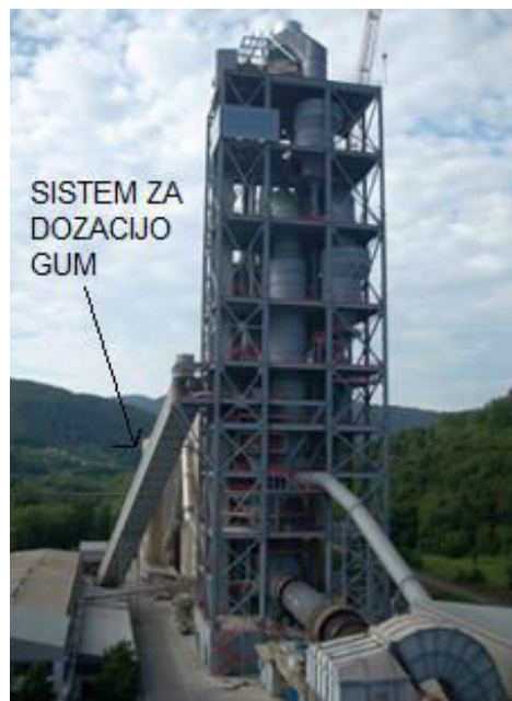
Slika 7: Lokacija sistema za doziranje gum na izmenjevalniku toplote.
