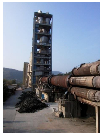
Slika 2: Star izmenjevalnik toplote brez dozirnega sistema za odpadne gume.
