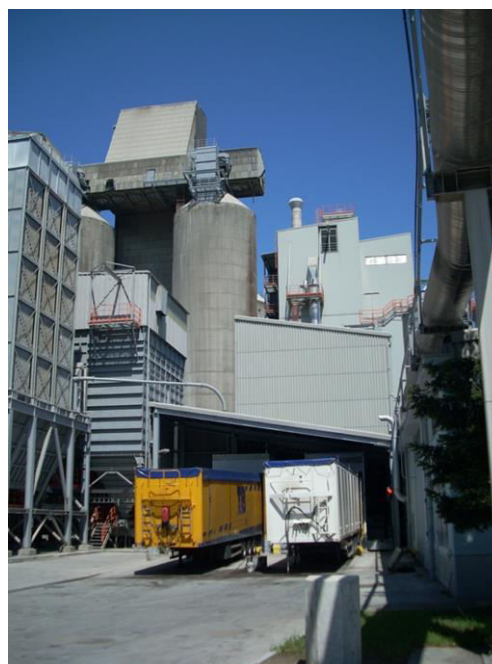
Slika 2: V ospredju prikolice s pomičnim dnom, v ozadju hala za doziranje alternativnih goriv.
