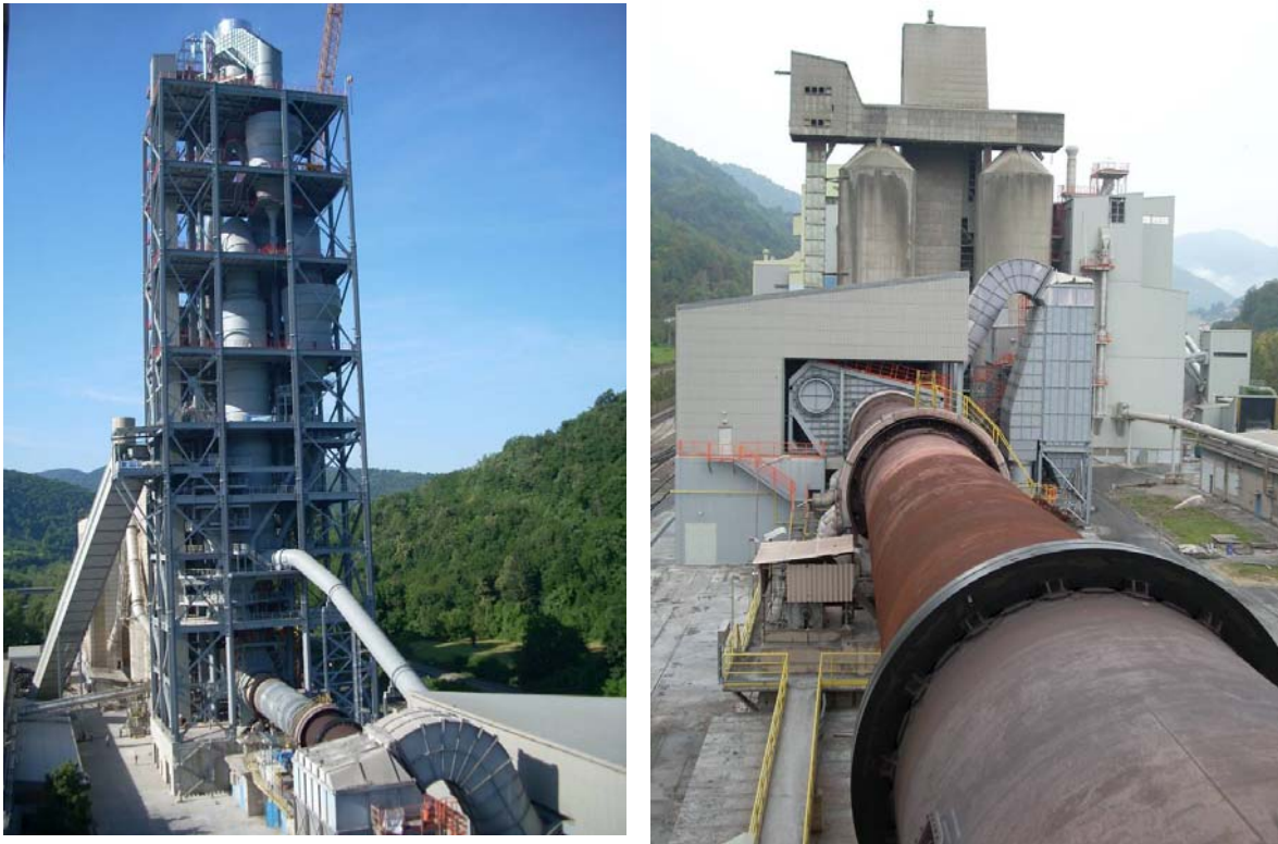
Slika 4: Proces proizvodnje klinkerja – posodobljene naprave
